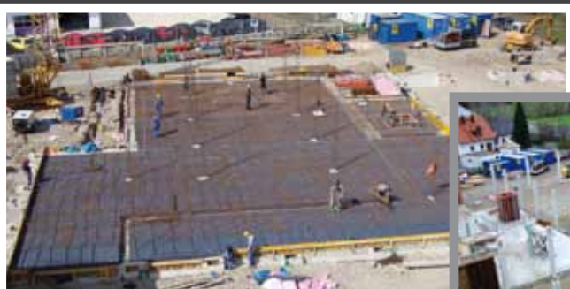
Bau einer Fundamentplatte
