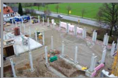
Pfeiler für die neue Ausstellung mit Lager
