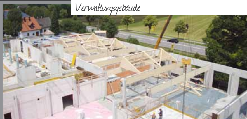
Leimbindermontage Bauteil 3
